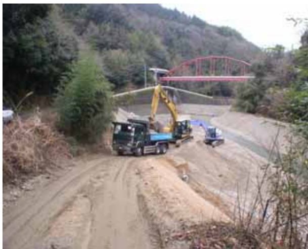
堆砂除去の状況（石手川ダム）
