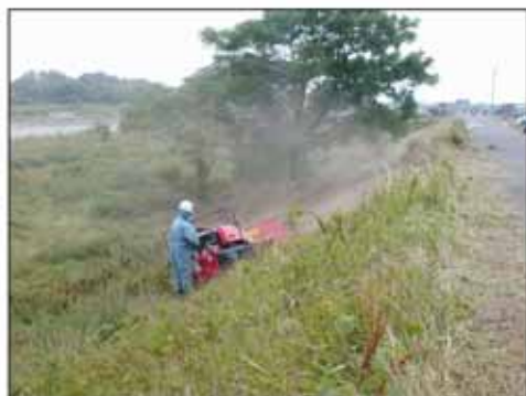
堤防除草状況
