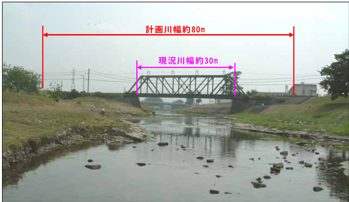
図-4.1.9 要改築構造物( J R石手川橋梁)箇所
